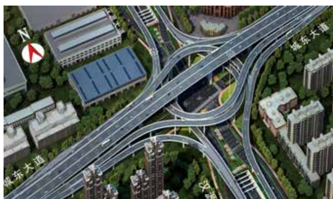
徐州市城东大道高架快速路项目 工程项目建筑信息模型服务荣誉白金级
