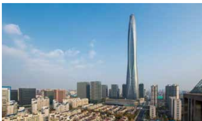
天津周大福金融中心项目 工程项目建筑信息模型服务荣誉白金级
