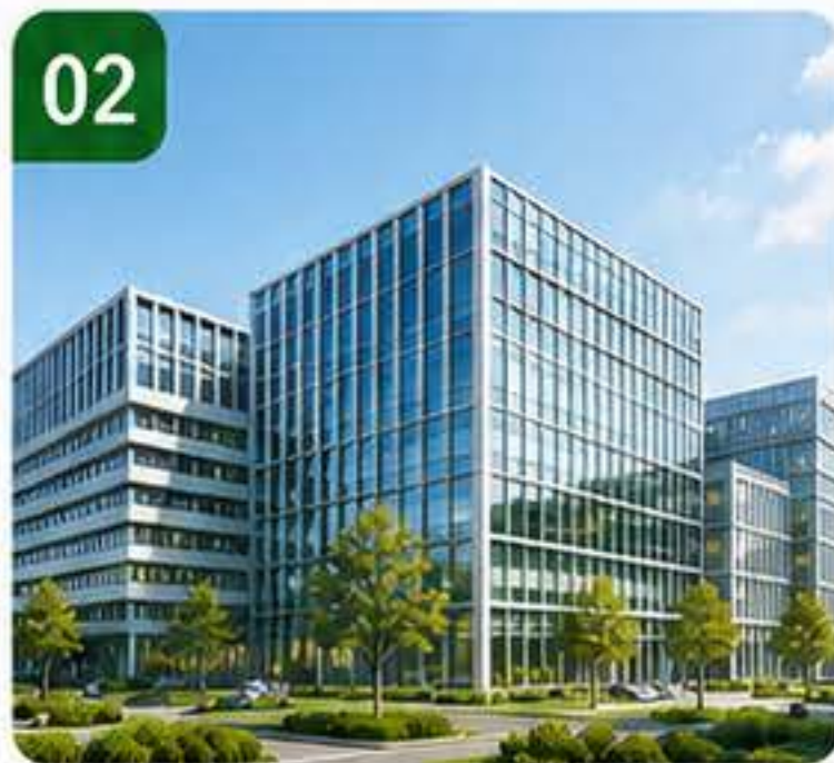
02 北京建工能源发展有限公司
