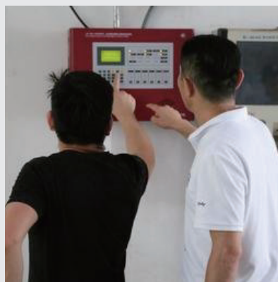
图3 消防安全专项检查
